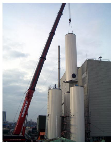
Plaatsen vijfde tank
