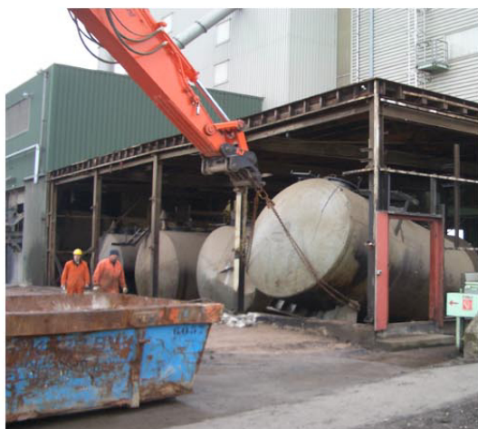
Sloop oude tanks
